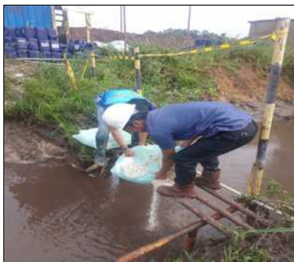
Gambar 4.6. Kegiatan Pengapuran pada Saluran Inlet
