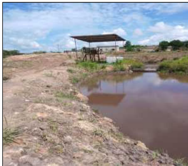
Gambar 4.8. Tempat Pencampuran Chemical Organic Coagulant dan Pengkapuran pada Saluran Outlet
