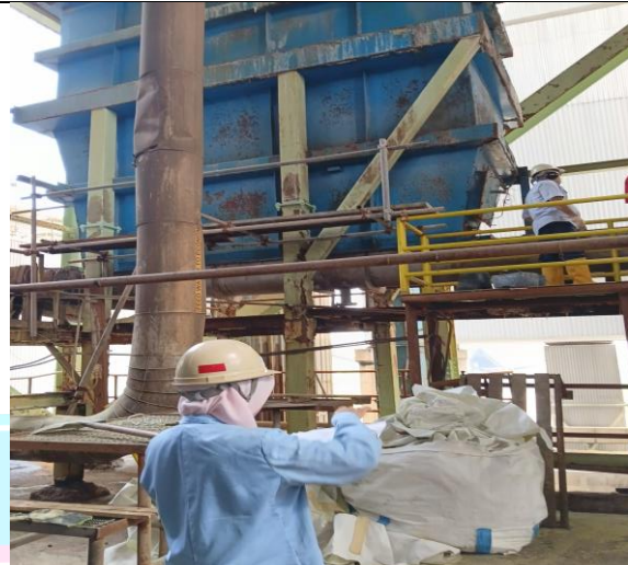
Kegiatan identifikasi bahaya dan risiko dari aktivitas kerja di Recovery Boiler
