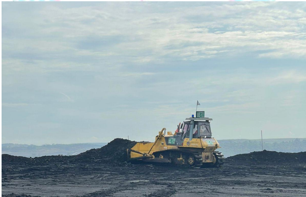
Gambar 4.4 Pemadatan Timbunan
