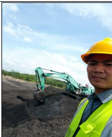
Gambar L. 3 Pengamatan proses penanganan swabakar menggunakan Excavator
