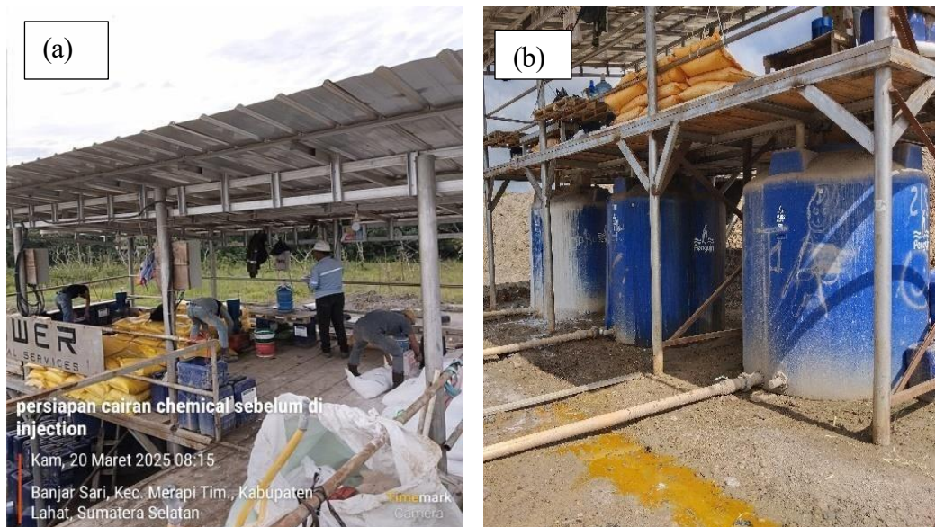
Gambar 3. 5 Persiapan Cairan Chimical Sebelum Injaction (a), Tandon Air Untuk Mixxing Chimical (b)
