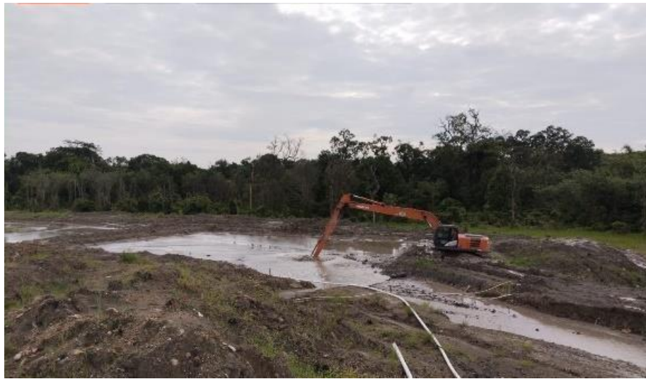
Gambar 4. 8 Proses Pengangkatan Lumpur
