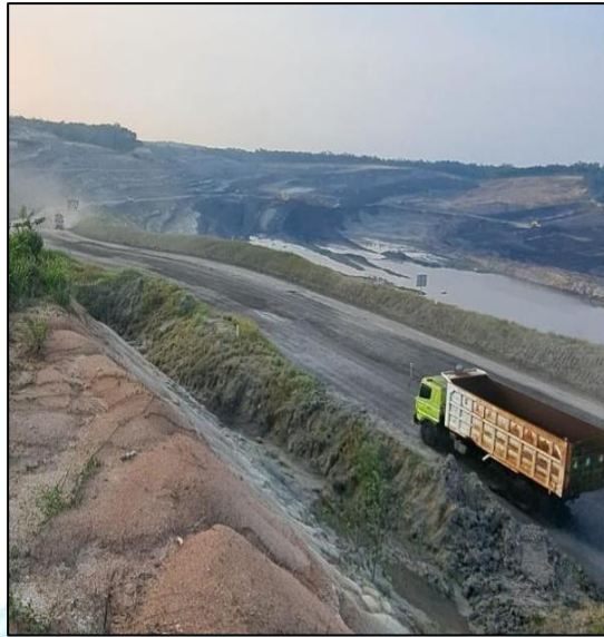
Gambar 4.3 Kondisi Jalan Tambang Ketika Kering
