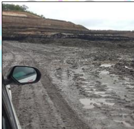
Gambar 4.4 Kondisi Jalan Tambang Setelah Hujan
