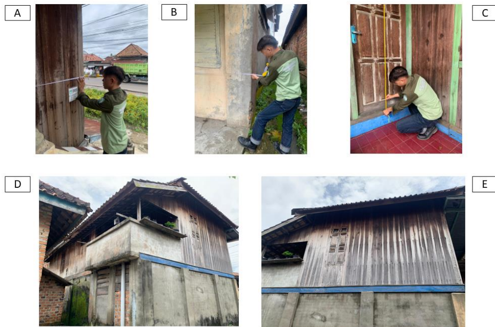
Gambar 2. Pengukuran rumah atap berbentuk L panjang samping kiri (A), lebar depan rumah (B), tinggi dan lebar pintu (C), lebar belakang (D), dan panjang samping (E).
