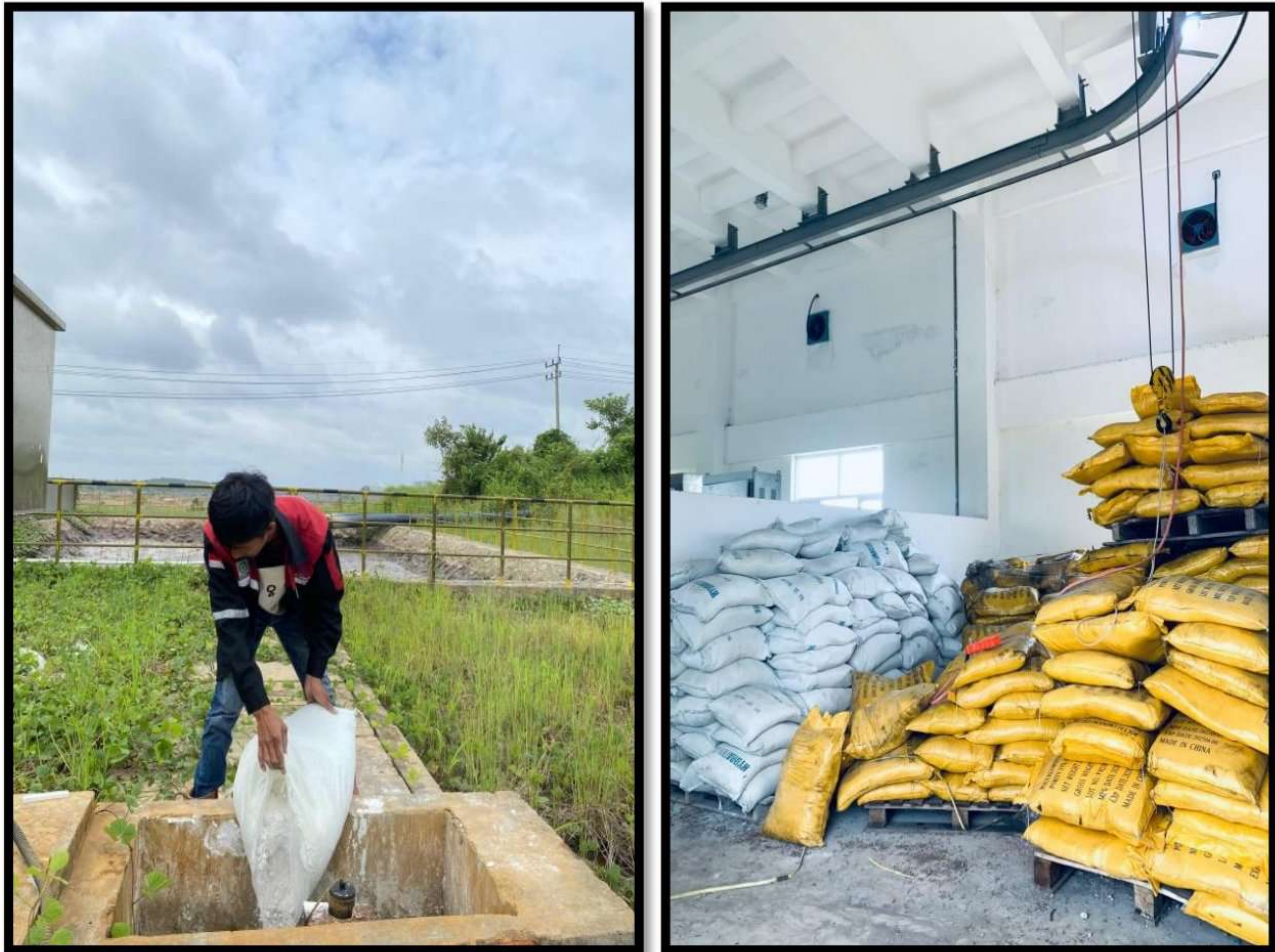
Gambar C.4. Pengapuran pada Saluran Inlet
