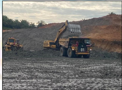
Gambar D.1 kondisi jenjang tidak standar
