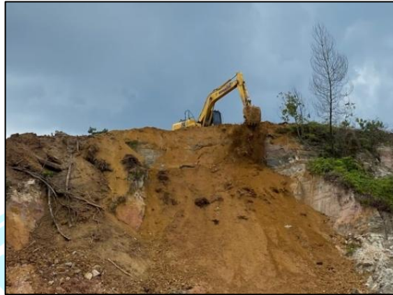
Gambar 4.5 Pengupasan Material di Area Lereng
