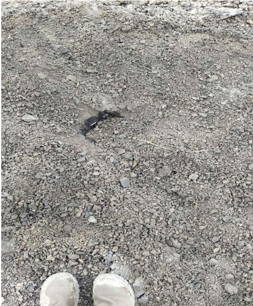
Gambar C.4 Lubang Bor Setelah Dimasukkan Stemming
