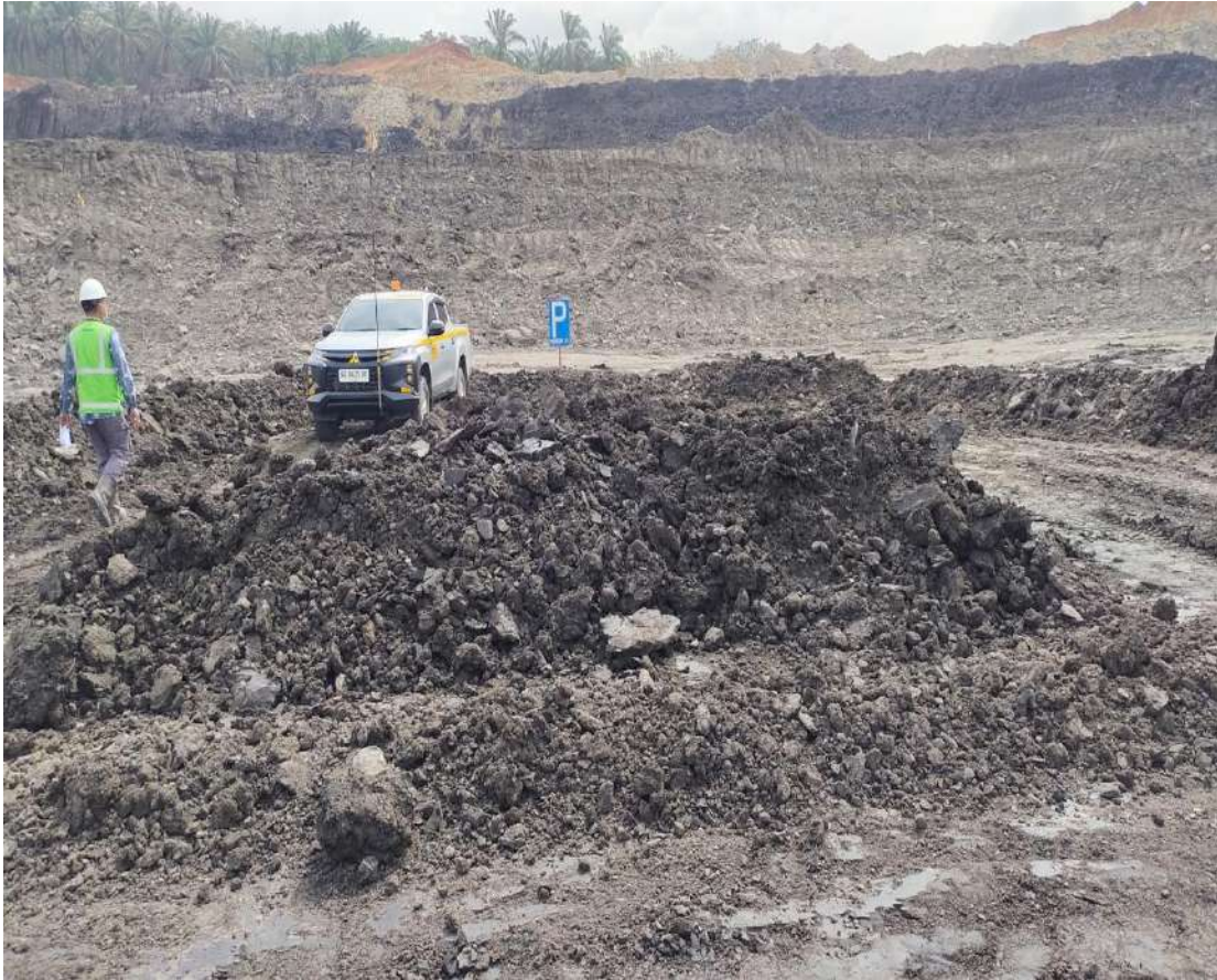
Gambar C.2 Area Parkir Lokasi Peledakan
