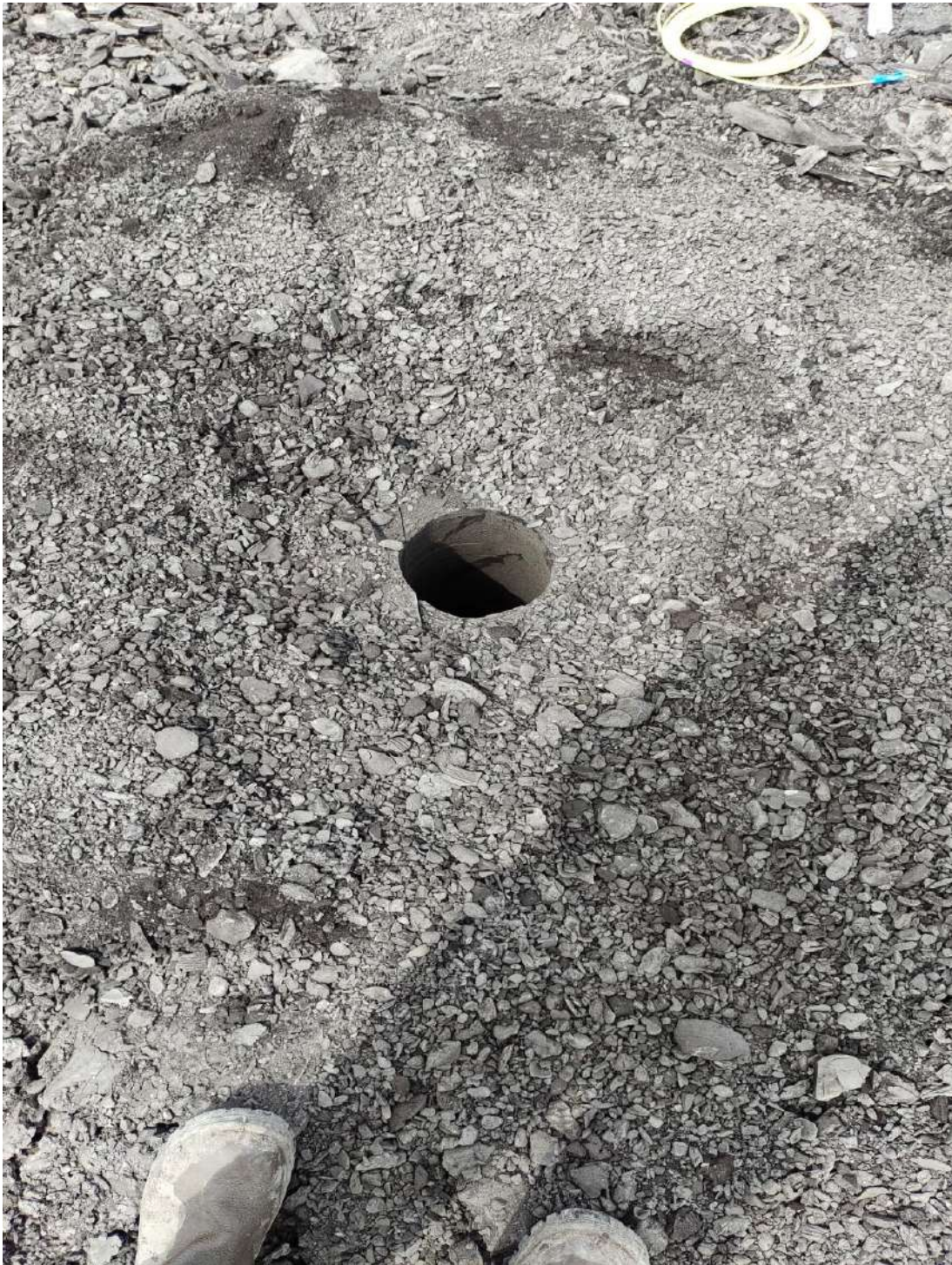
Gambar C.3 Lubang Bor Sebelum Dimasukkan Stemming
