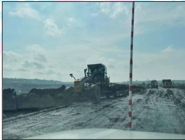
Gambar 4.5 Pemeliharaan Jalan Hauling
