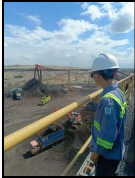
Sumber : Penulis, (2025). Gambar E.1 : Kondisi Area Stockpile Batubara
