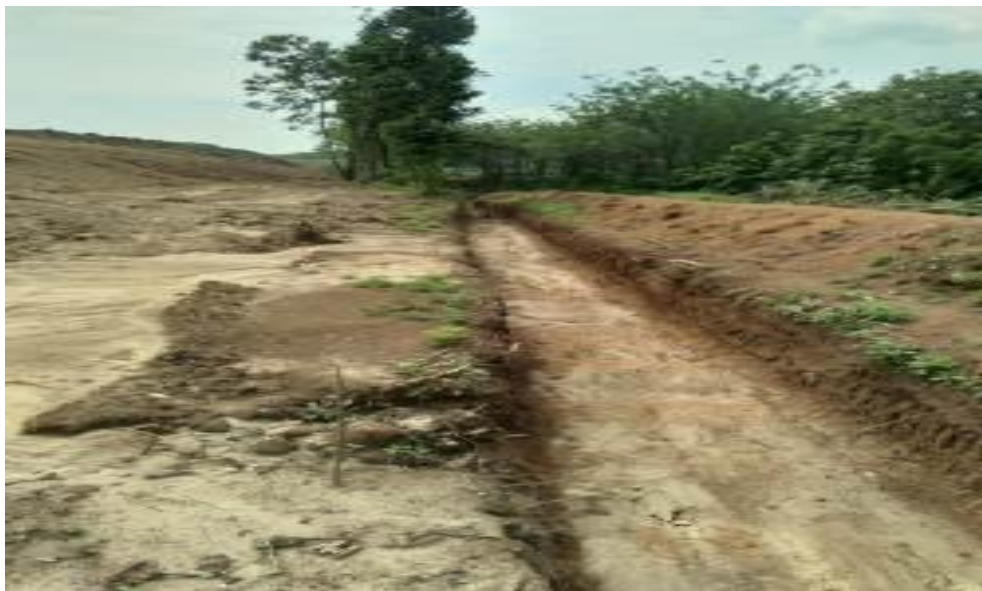
Gambar 2.6 Parit drainage di sekeliling tambang
