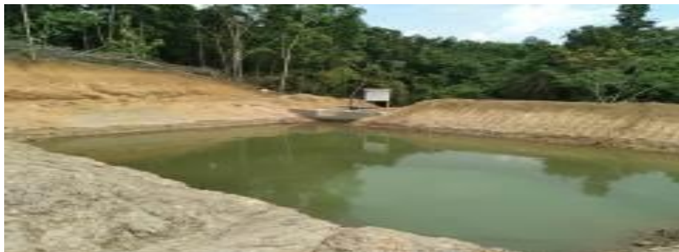
Gambar 2.7 Kolam pengendapan ( settling pond ) untuk air limpasan batubara dari tambang
